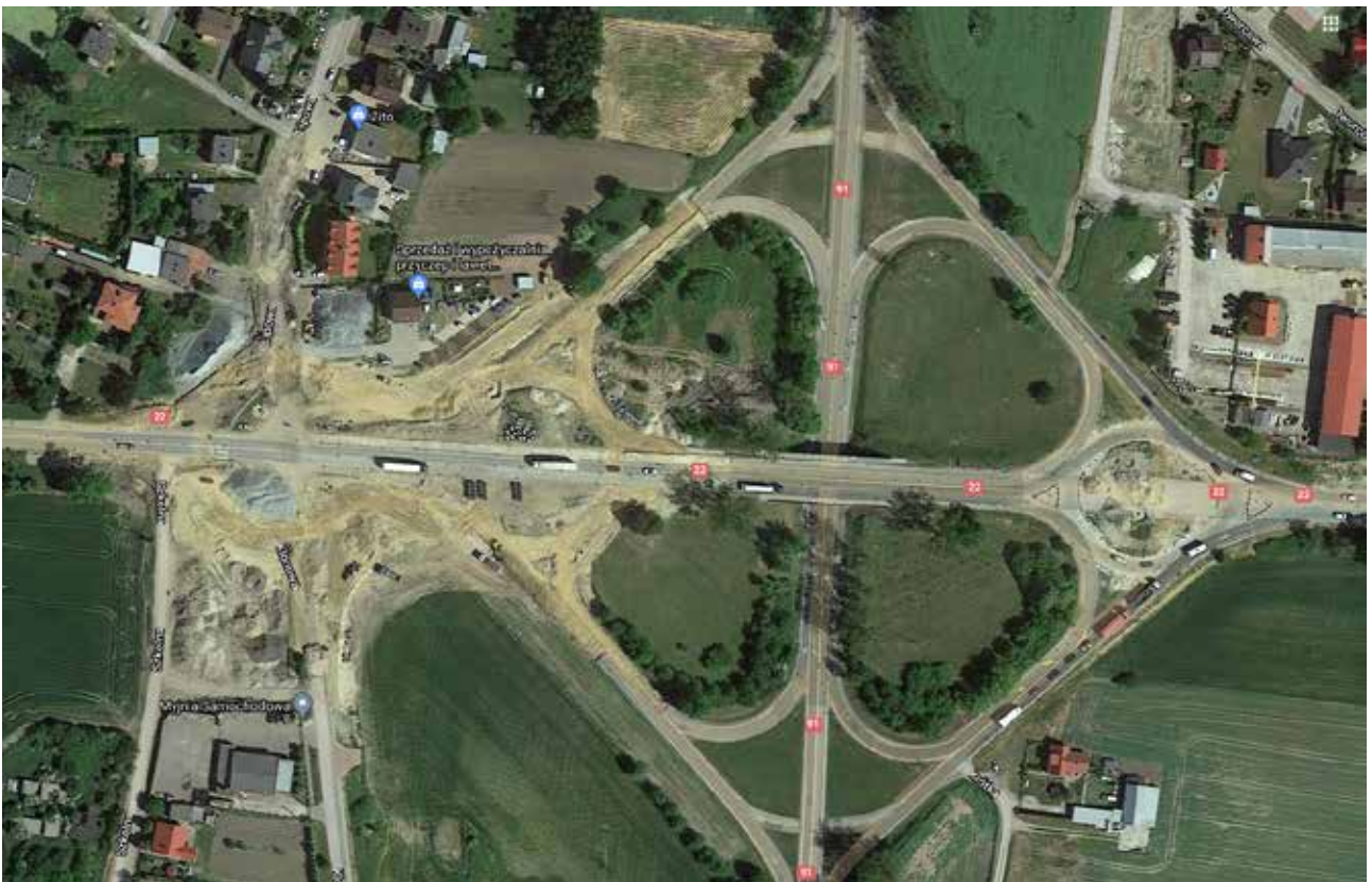
Lidt vest for Most Knybawski broen er der et spændende kløverblads autobahn kryds. Krydset er desværre blevet bygget om af to omgange, men de originale konturer ses stadig tydeligt. En lille del af strækningen af hovedvejen er stadig med brosten som vejbelægning (Google Maps).
