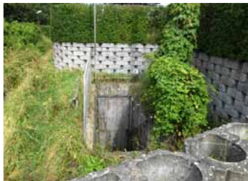
Den godt skjulte nedgang til bunkeren ved Vestergade 115. Foto: Museum Skanderborg.
