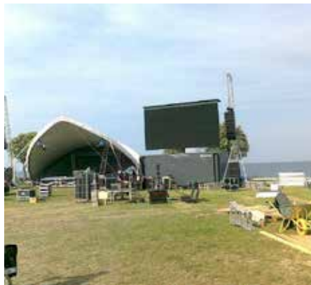
Store scene med storskærm under opbygning
