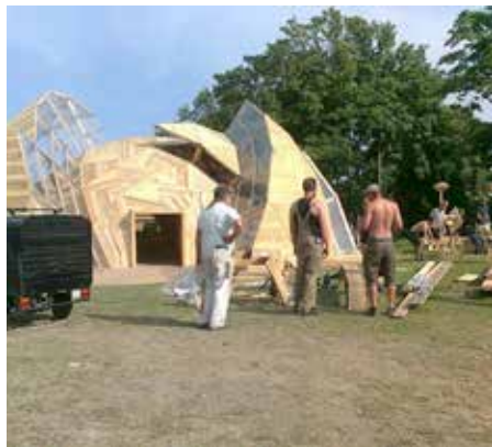
Den imponerende dome på cirkuspladsen under opbygning
