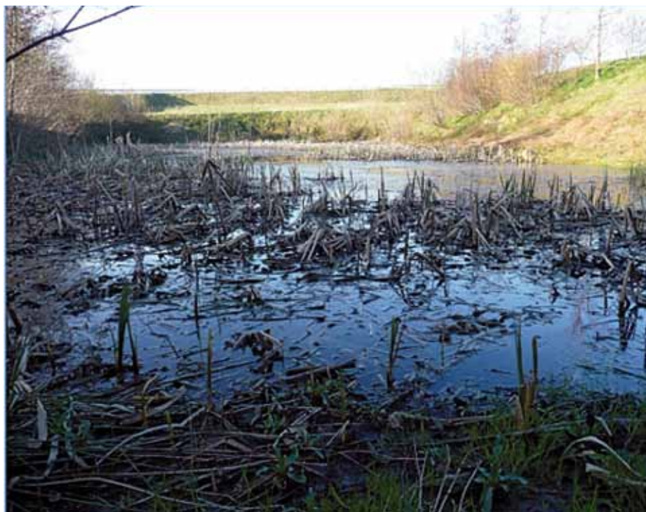
Figur 2. Et vådt regnvandsbassin til rensning af vejvand.
