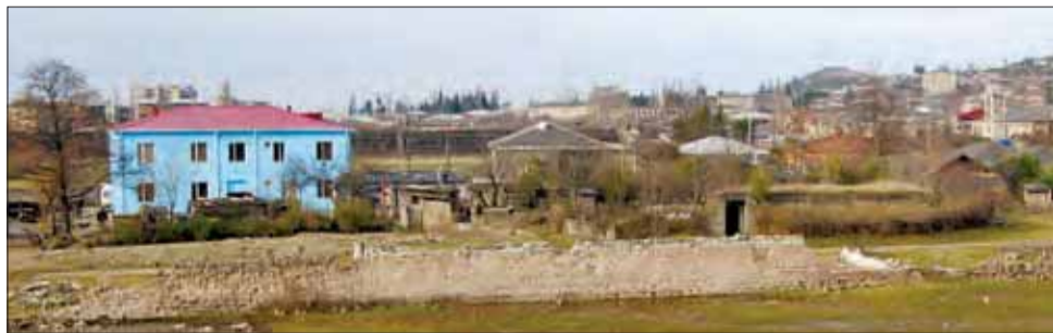
Efter endt renovering står et af de gamle flygtningekollektiver klar, og beboerne kan tage hul på et nyt kapitel. Foto: Mikkel Noel Lanzky
