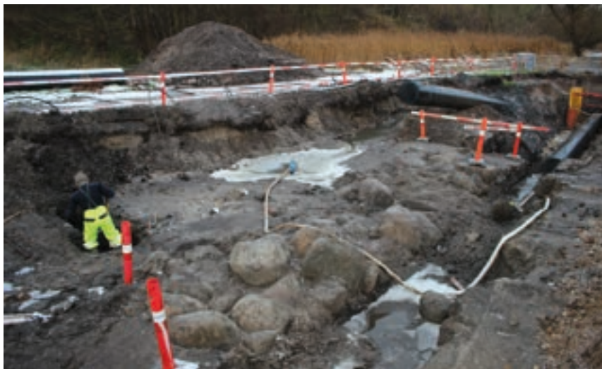
↑ Fig. 1. Udgravningen i Lejre Ådal foregik i november-december 2021 under yderst vanskelige vilkår: Dykpumpen er placeret midt i den gamle møllekanal, og de nedrammede egepæle er markeret med gule pinde. Foto: Ole Kastholm, ROMU.
