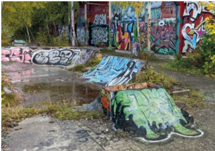
↓ Fig. 15. Ældre ramper udenfor hallen. Planen er, at der skal bygges parkeringshus her. Foto: Cille Krause.
