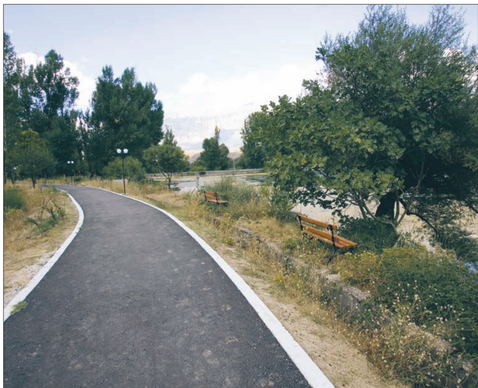
Nylagt asfalt langs forurenede udflugtsmål. Foto: Klaus Holsting
