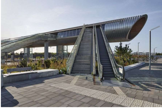
Køge Nord Station fra 2019 giver med sin futuristiske sansning af fart og udvikling jernbanens linjeføring over Ringsted et skub ud i fremtiden. Foto Flemming Wedell
