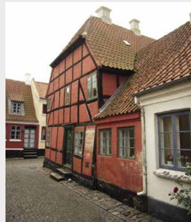
Hammerichs Hus, Gyden 3 med nuværende indgang til museet. Tilbygningen er fra begyndelsen af 1900-tallet og rummer bryggers og sengekammer i museet. Foto 2014, Kirsten Lindberg.
