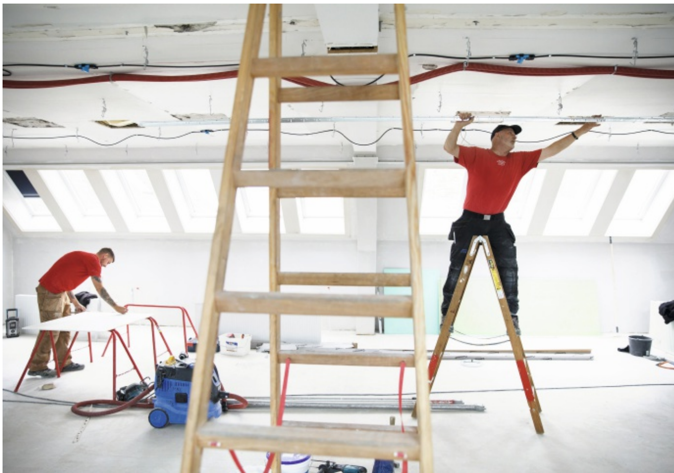
Før Nota kan flytte ind i Nakskovs gamle rådhus, vender Bygningsstyrelsen bunden i vejret på det hele. De lokale synes godt nok, det ser dyrt ud.
