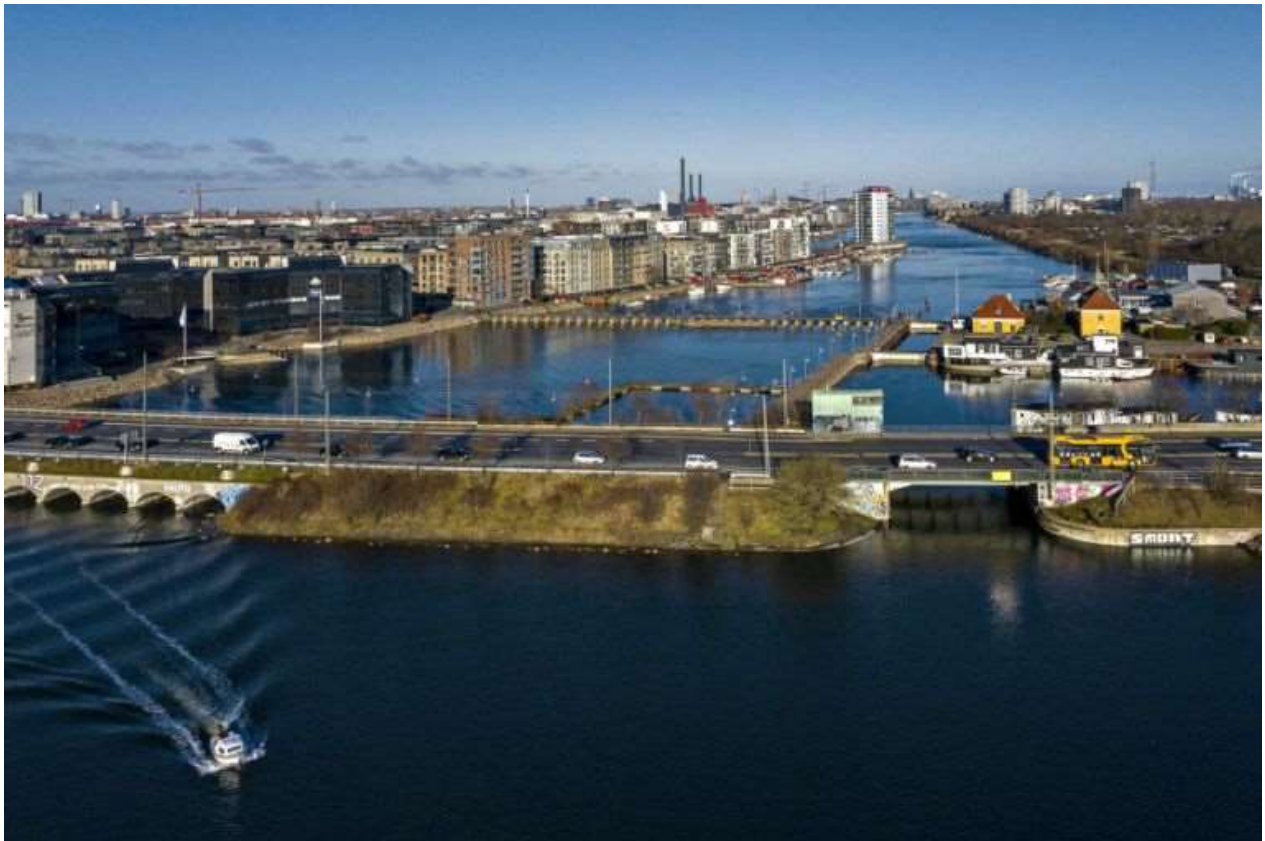
Sjællandsbroen over havneløbet i Københavns Havn forbinder Sjælland med Amager og Københavns Kommunes bydele Vesterbro-Kongens Enghave med Amager Vest. Broen blev åbnet i 1959 og tillod passage af mindre skibe ved hjælp af to broklapper. Passage blev dog umuliggjort efter åbningen af en fast jernbanebro på Sjællandsbroens sydside i 1998 i forbindelse med etableringen af Øresundsforbindelsen. Foto: Jens Nørgaard Larsen/Trap Danmark, 2020.
