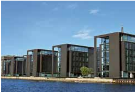
Christiansbro (opført i 2000), Nordeas danske hovedsæde, hører til blandt de mange nye prestigebyggerier på Københavns havnefront. Højden er mere ydmyg end den eksklusive adresse – og typisk dansk: de 55.000 kvadratmeter er fordelt på kun 6 etager. (Foto: Steven Ballegeer)
