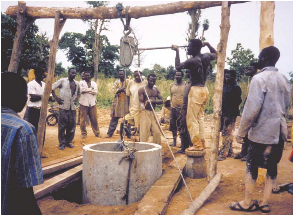
Landsbyboere i Affem Kabye i Togo bygger en brønd ved at sænke cementringe ned med en mekanisk trisse. Arbejdet er en del af et EU-udviklingsprojekt.
