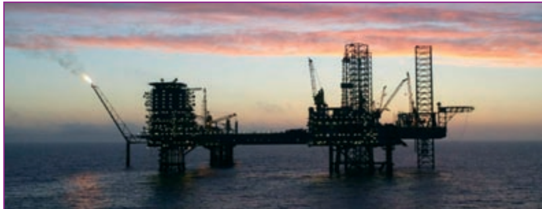
Olieboreplatformen Dan (Foto: Mærsk Olie og Gas AS).
