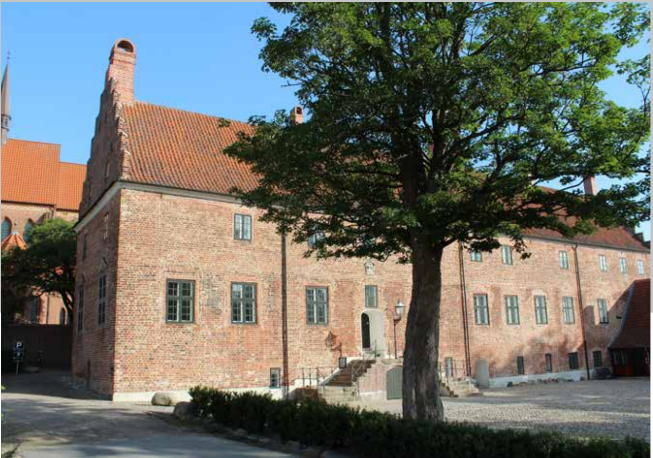
Fig. 1. Den bevarede nordfløjen i den senmiddelalderlige bispegård i sin nuværende udformning. Bygningen til højre i billedet er af nyere dato, men ligger på den middelalderlige østfløjs placering. Foto: Odense Bys Museer.
