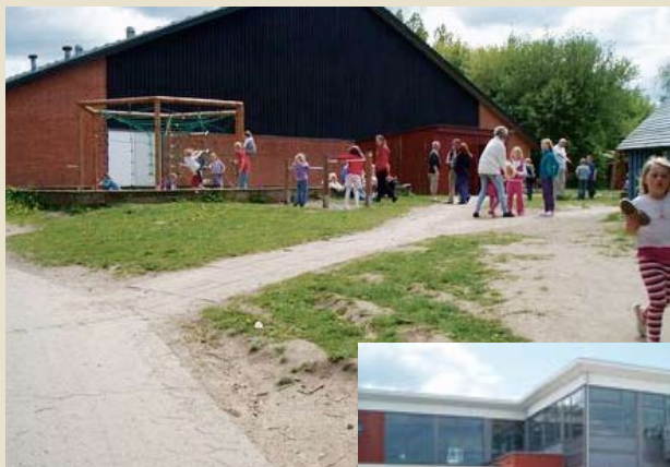
Hyllehøjskolen i Middelfart er en folkeskole. Den har for nylig gennemgået en større renovering, blandt andet energirenovering vha. ESCO-modellen.
