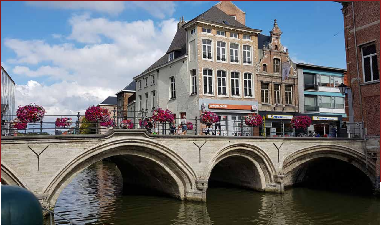
Grootbrug eller Hoogbrug i Mechelen er en af de ældste stenbyggede broer i Flandern, der stadig er i brug. Den er opført af sandsten i det 13. århundrede men er i nyere tid blevet forstærket med en betonplade for at kunne bære den kørende trafik. Foto: Per Winther.
