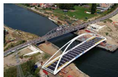
Luftbillede af broanlægget ved Herentals-Lierseweg. Den nye bro midlertidigt placeret til højre for den eksisterende, der skal nedbrydes.
